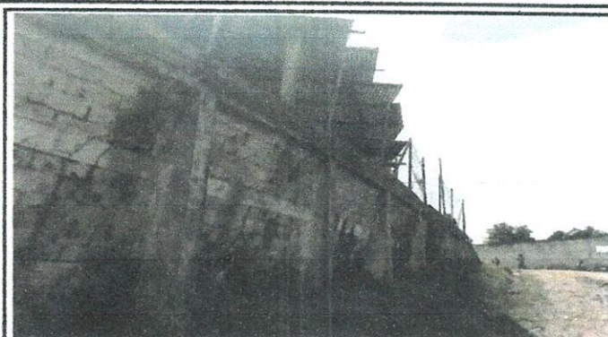
Foto 2: Reparación de Muro de Contención con reforzamiento con cuneta y drenes, lado sur del centro educativo
