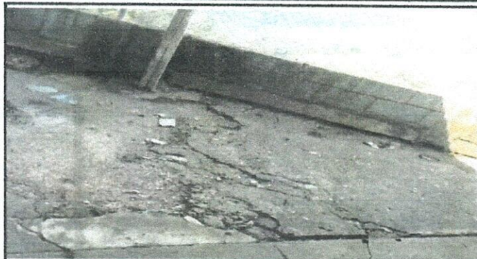
Foto 1: Reparación de Muro de Contención con reforzamiento con cuneta y drenes, lado sur del centro educativo
