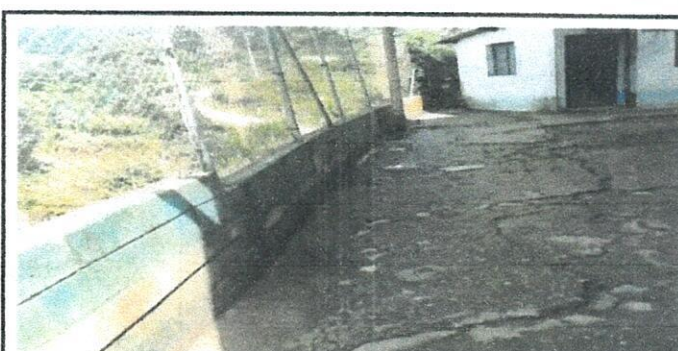
Foto 6: Reparación de Muro de Contención con reforzamiento con cuneta y drenes, lado sur del centro educativo
