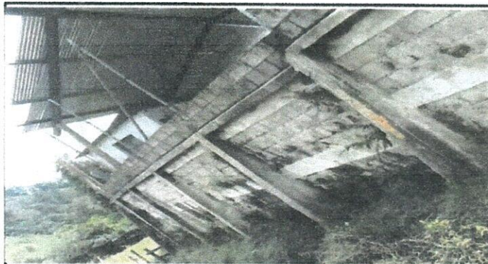
Foto 3: Reparación de Muro de Contención con reforzamiento con cuneta y drenes, lado sur del centro educativo
